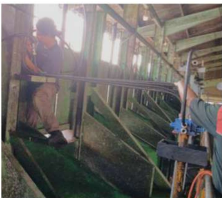
Penggantian Sistem Hidrolik Loading Ramp, Aceh
