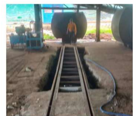
Penggantian Rail Track Jalur TBS, Kalimantan Barat
